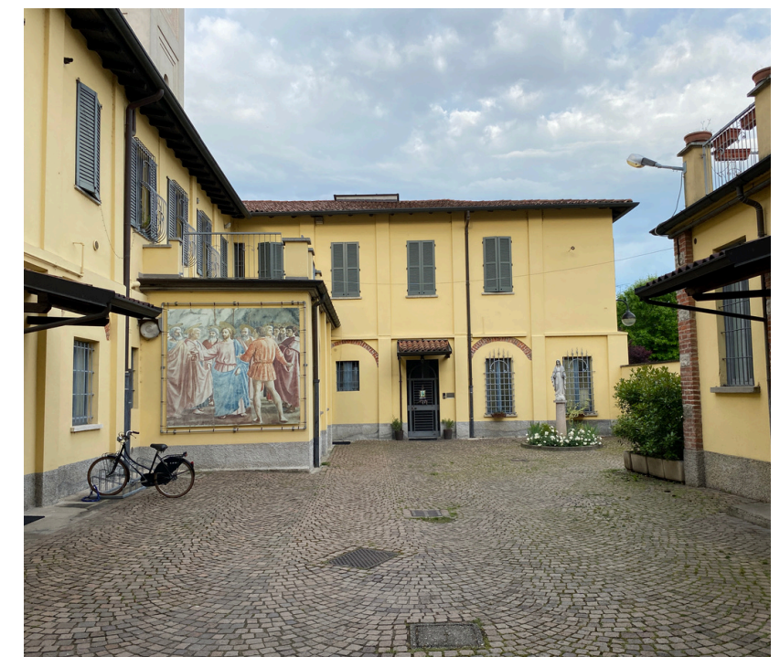
Il circolino (vista del cortile interno)
